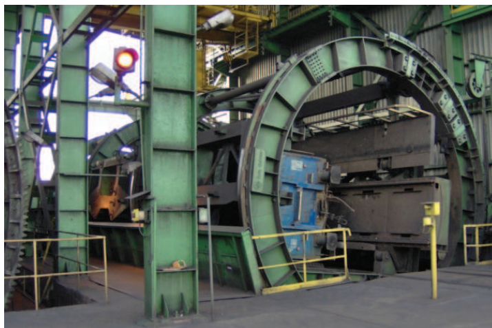
Rys. 1. Wywrotnica wagonowa – strona wyjazdowa (opracowanie własne)
