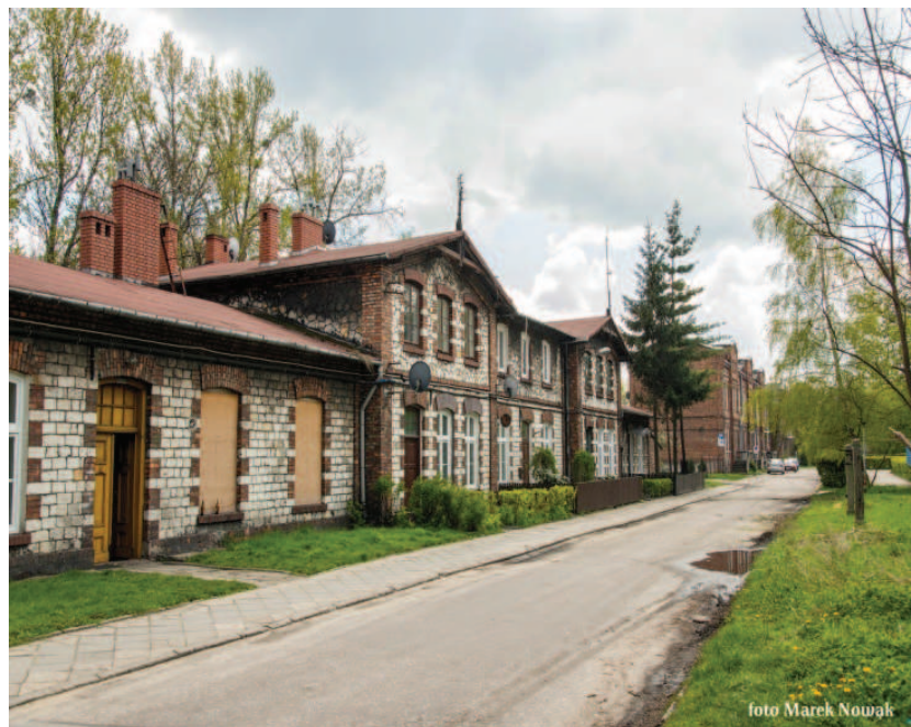
Fot. 12. Budynki mieszkalne „Elanexu”
