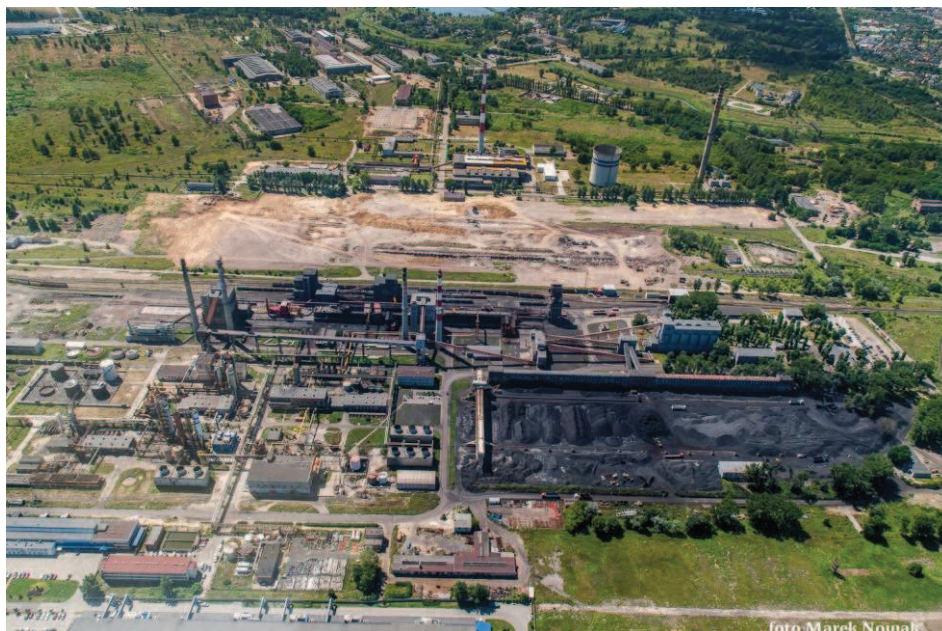
Fot. 2. Teren dawnej koksowni ISD Huty „Częstochowa”
