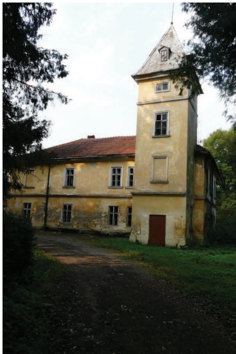
4. Wisznia (Beńkowa Wisznia), obwód lwowski, rejon samborski, zespół pałacowo-parkowy Fredrów. Elewacja wschodnia tzw. dużej oficyny, widok od strony północno-wschodniej, stan we wrześniu 2011 r. Fot. Czesław Hadamik.
