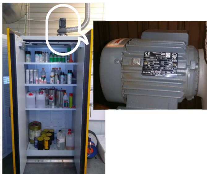
Rys. 3. Szafa na odczynniki chemiczne z wentylatorem w wykonaniu Ex
