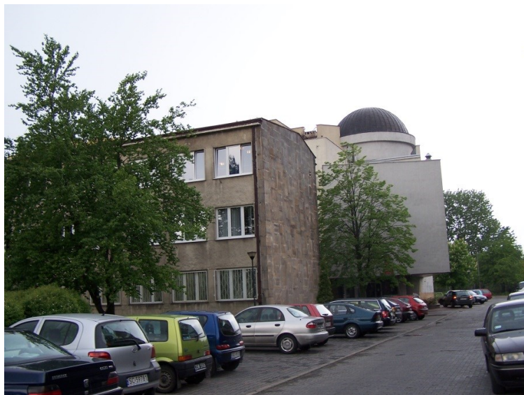
Fot. 6. Wygląd obecny budynku Wydziału Nauk Ścisłych, Przyrodniczych i Technicznych UJD z kopułą kina sferycznego.
