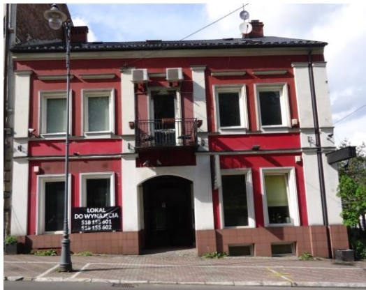
Fot. 3. Aktualne zdjęcie budynku dawnego MH na ul. 3 Maja Źródło: archiwum prywatne autorów.
