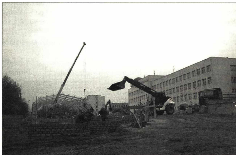
Na budowie Akademickiego Centrum Sportu (prace w listopadzie), fot.: arch.
