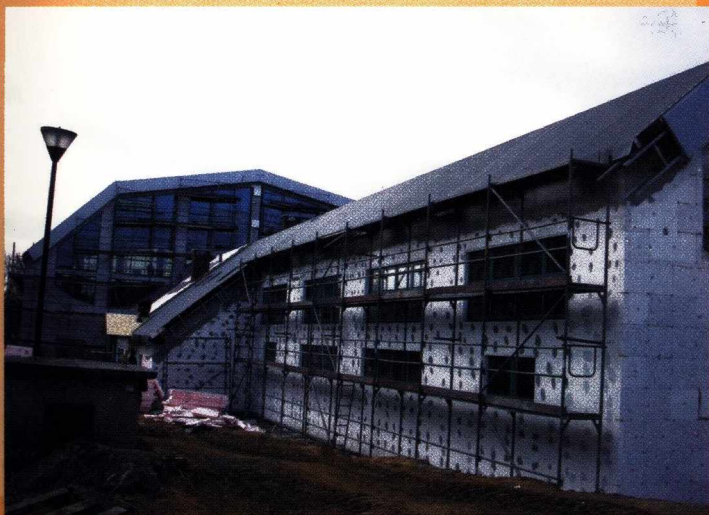
Trwają prace budowlane Akademickiego Centrum Sportu przy ul. Dembińskiego
