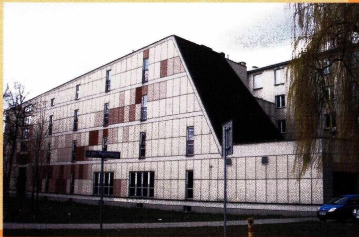
Wybudowany nowy Magazyn Książek Biblioteki Głównej
