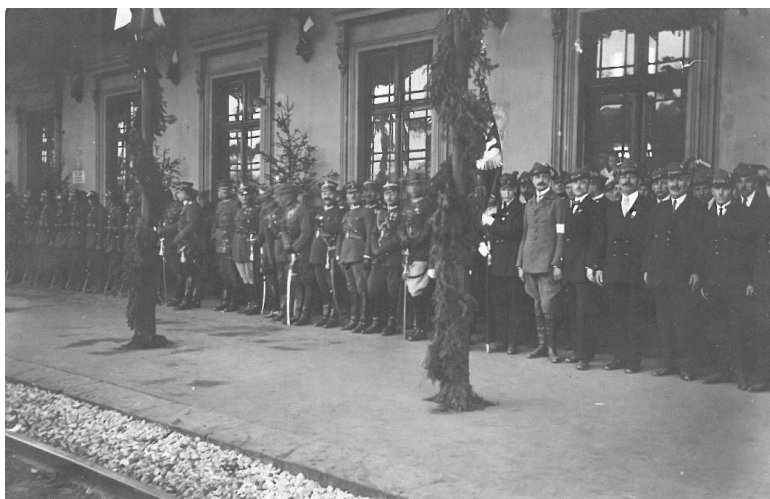
Fot. 5. Dworzec w Częstochowie, oczekujący na przyjazd Ferdynanda Focha
